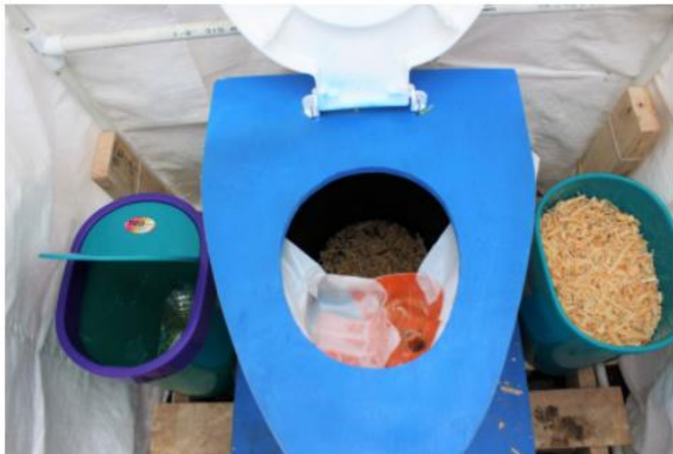
Letrina seca con separación de líquidos y sólidos.
