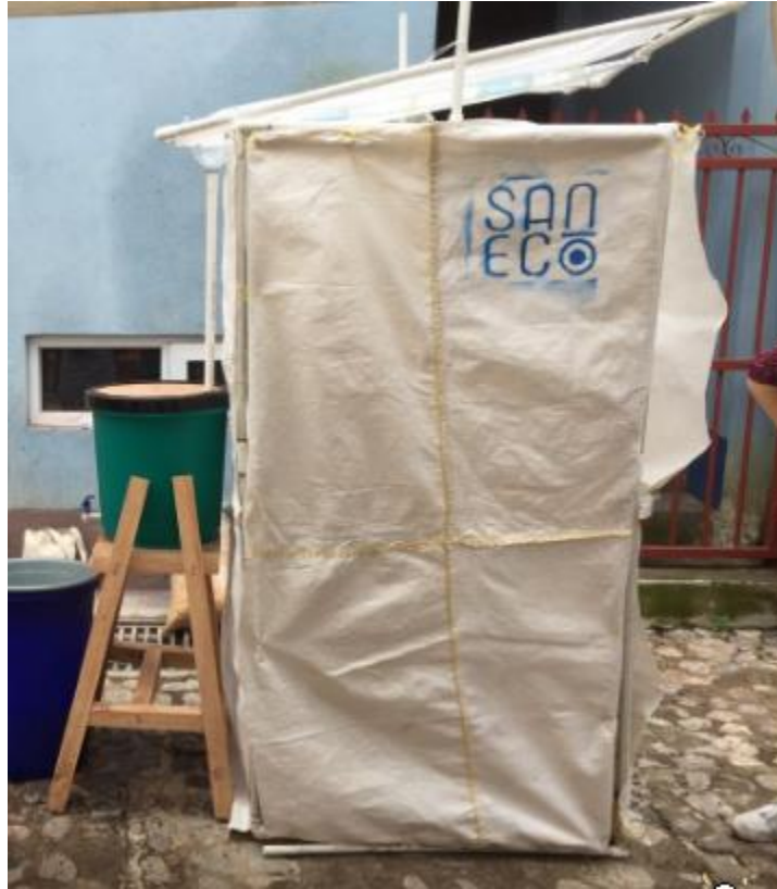
Montaje de prototipo completo, se observa la inclinación del techo para captar agua, la estructura de PVC con puerta y recubrimiento de costales y la estación de lavado de manos al costado.
